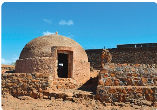
Fig. 7 Fortaleza Real de S. Filipe, Ribeira Grande de Santiago. No final do reinado de Filipe II de Espanha, em 1597, já estava construída.
