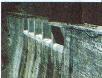
Aspecto da barragem de Poilão
